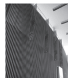
羽板（ルーバー）形状の木質プラスチック複合材の施工例
